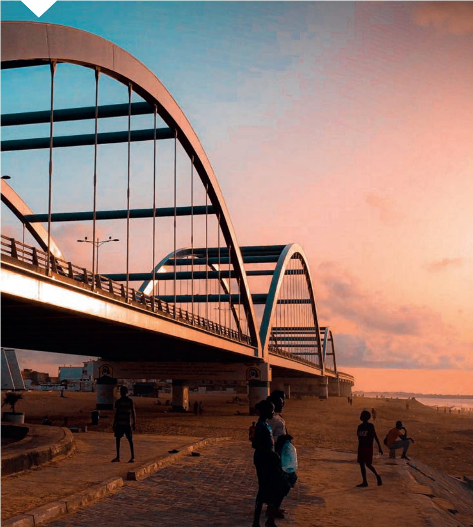
Cambéréne Bridge, Dakar, Senegal
